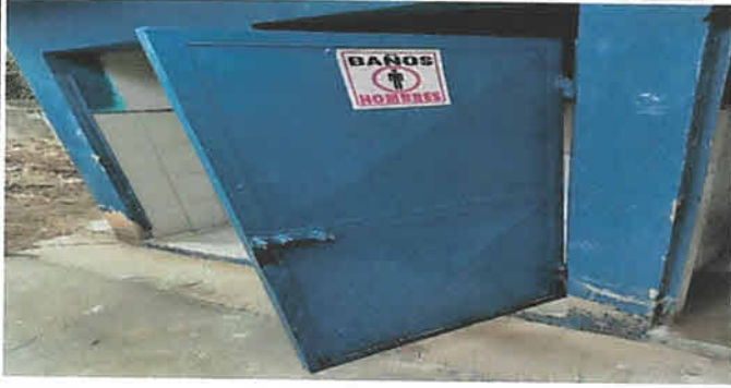
Foto 7: Mantemiento de Puertas de los baños
