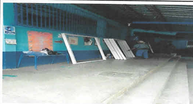
Foto 2: Instalacion de ventanas PVC
