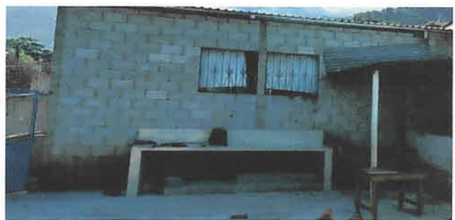
Foto 18: Techado en el area de pila frente a cocina
