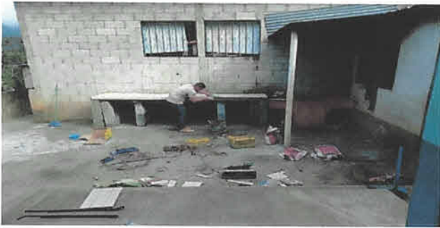
Foto 15: Construccion de desayunoador
