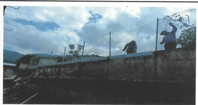
Foto 12: Reparacion de muro perimetral
