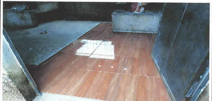
Foto 14 : Cambio de torta de cemento por ceramica
