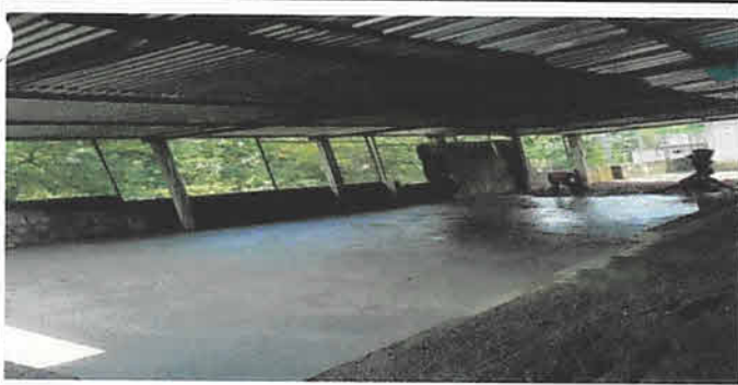
Foto 11: Reparacion de torta de cemento en area de actividades
