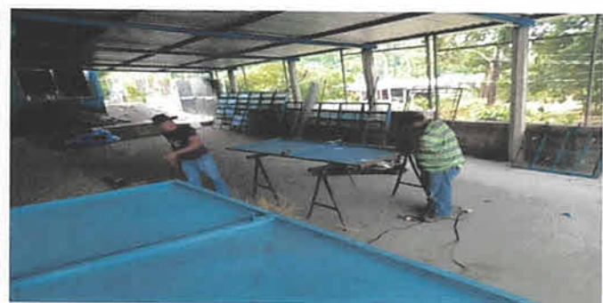
Foto 4: Mantemiento de Puerta, lijado, cepillado y pintura
