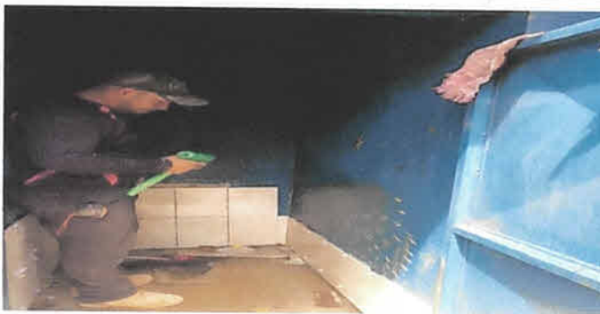
Foto 9: Mantemiento de paredes de sanitarios por azulejos
