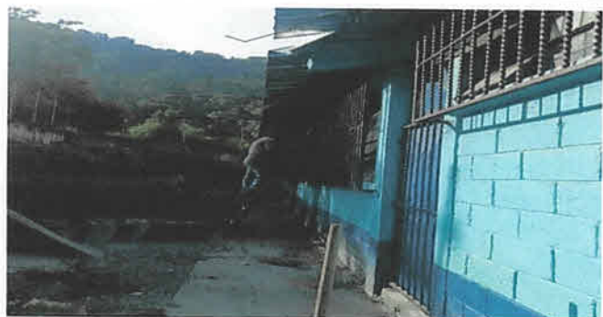
Foto 3: Desmontaje de lamina en el aula parte de atrás
