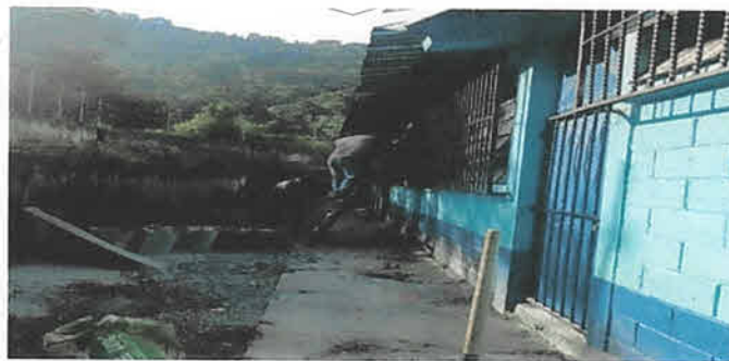
Foto 5: Mantemiento de Balcones, lijado, cepillado y pintura color azul anticorrosicbo
