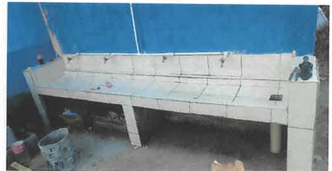
Foto 10: Colocacion de azulejos y lavamanos
