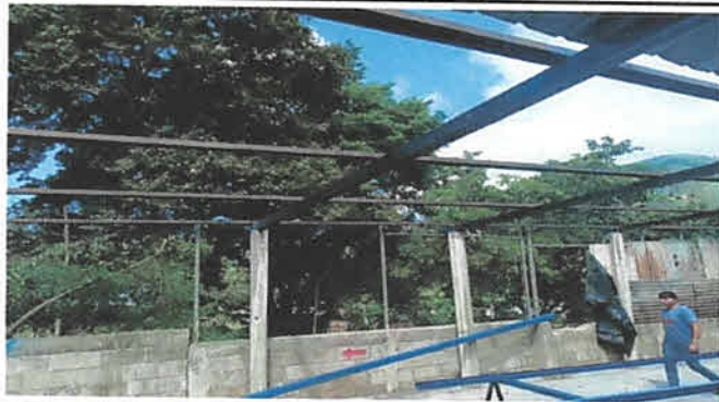
Foto 1: desmontaje de laminas en area de actividades
